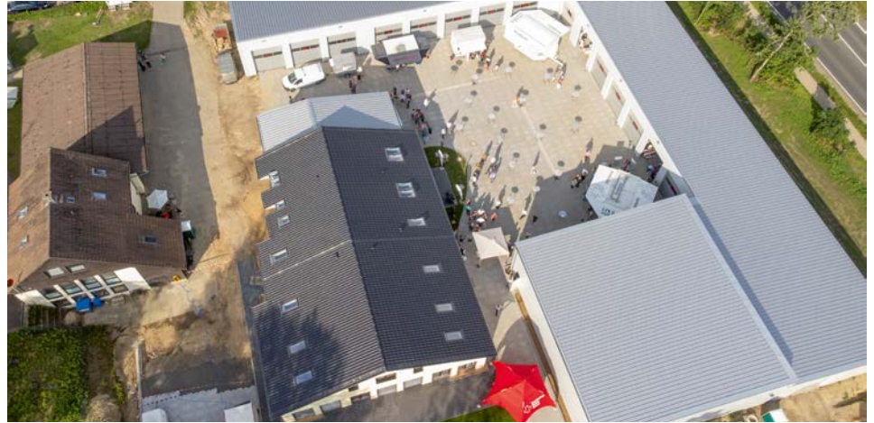
Luftaufnahme des neuen DRK-Katastrophenschutz- und Schulungszentrums
